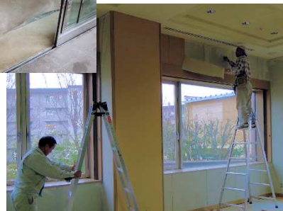
多目的室の壁紙 張り替え工事 →
