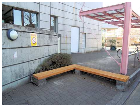
新しい木材の腰掛部で補修されたベンチ (原山小学校側通路に面した2か所)
