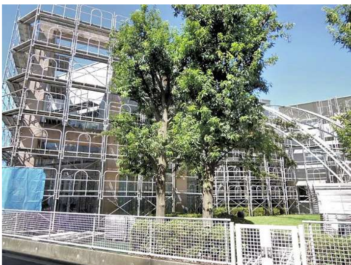
写真は、8月26日現在の建物外観です。
